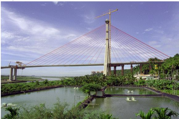
Übergang vom Hügelland bei der Vier-Millionen-Stadt Kaoshiung in die Ping-Tung-Ebene darstellen. Die Balance der auf ungleiche Feldweiten aufgeteilten Brückenkonstruktion konnte erreicht werden, indem das kurze Feld in Beton und das lange in Stahl ausgeführt wurde. Erfreulich für das Wiener Unternehmen war auch die Tatsache, dass die örtliche Bevölkerung positiv auf das Projekt reagierte und die Eröffnung der Brücke mit einem großen Volksfest feierte.
